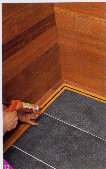
13 On colle un adhésif sur le raccord entre le bois et les carreaux, puis on le fend au cutter pour dégager le joint et le remplir du mastic souple extrudé au pistolet. Le surplus est arasé.
