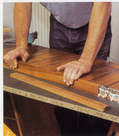
L'alèse rapportée sur le chant est collée. Elle doit être maintenue sous presse durant le séchage.
