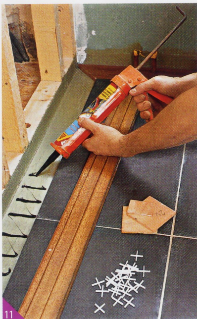
11 À l'emplacement des lames de parquet, la colle s'applique en cordons directement sur l'enduit d'étanchéité, et impérativement dans le sens opposé à celui des lames.
