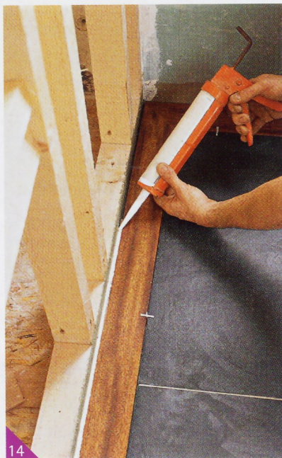
14 Au pied des cloisons, autour de la pièce, le mastic élastomère souple est appliqué en cordon continu. Il sert à absorber les jeux de dilatation naturels du bois sans se fissurer.
