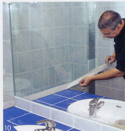
10 Sans attendre, on décolle le ruban de masquage. Le séchage complet du joint intervient 8 heures après le remplissage.
