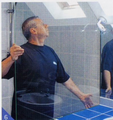
6 Introduite dans le U, la paroi vitrée repose sur les cales adhésives et s'ajuste à quelques millimètres du miroir et du rampant.
