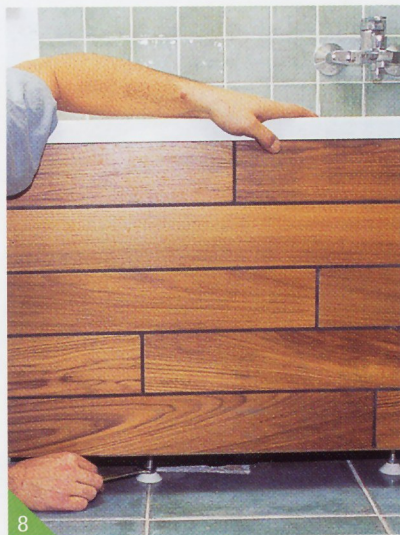
8 Bloqué sous le rebord de la baignoire, le tablier est réglé d'aplomb, puis les vérins sont bloqués.
