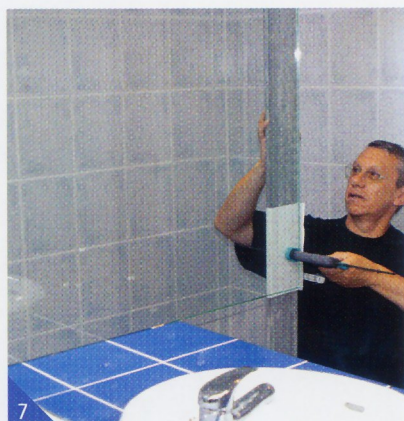
7 On bloque une règle contre la paroi haute en interposant un papier. La paroi du bas s'appuie contre elle et repose sur des cales en liège.
