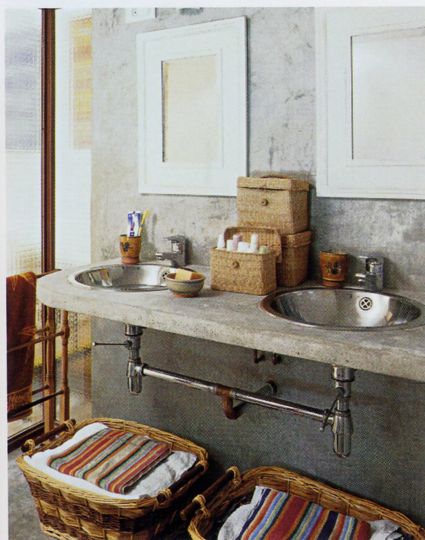
Le granito dans lequel est fabriqué ce plan intègre un mélange de ciment blanc, de granulats de marbre, de pâte de verre et de nacre. L'ensemble est malaxé avec des plastifiants qui l'imperméabilisent. © Réalisation Société Granito. Architecte G. Percal. Photo A. Duarte.
