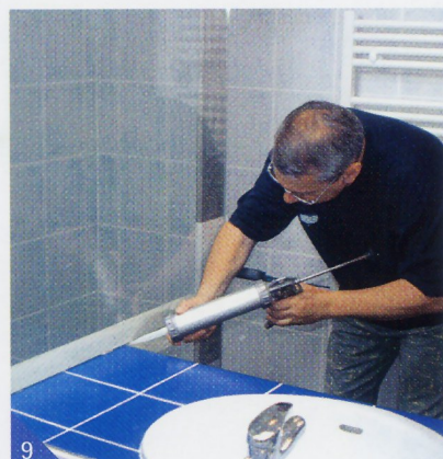
9 Pour remplir le joint, on procède de chaque côté de l'écran. Le mastic translucide est déposé en cordon continu et régulier.
