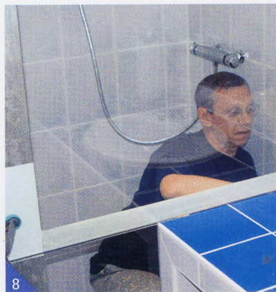
8 Le ruban de masquage se colle avec précision des deux côtés du joint, pour protéger le verre des éventuels reflux de mastic.
