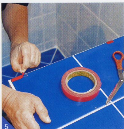
5 Au bord du plan de toilette, on répartit les cales adhésives double face. La pellicule qui protège l'adhésif est décollée ensuite.
