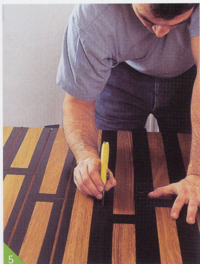
5 Sur les rubans adhésifs collés sur tous les raccords, on fait une incision franche pour dégager les intervalles.
