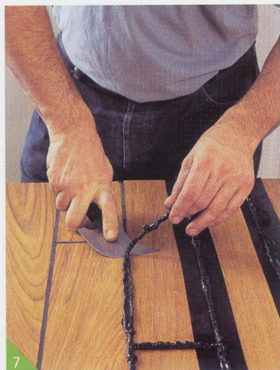
7 Les adhésifs sont dégagés tour à tour lorsque le mastic est sec. Il peut ensuite être arasé avec le couteau.
