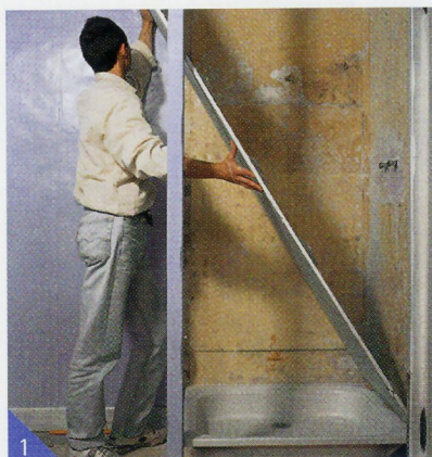
1 Les plaques de plâtre hydrofuges conviennent aux parois irrégulières, dont elles rétablissent la planéité en jouant sur l'épaisseur des plots de colle.
