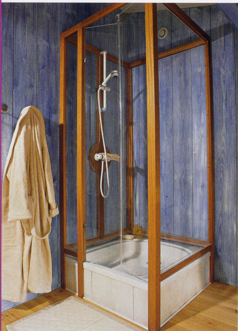
Encastré dans un socle en polystyrène, le receveur en matériau de synthèse s'entoure de parois en Altuglas permettant de profiter du décor mural en iroko. Les portes « saloon » s'articulent vers l'intérieur. © Photo Ph. Louzon.
