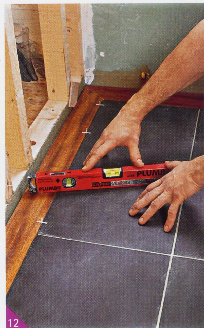
12 Les croisillons sont remis en place avant de coller les lames. La planéité est contrôlée avec un niveau. La différence d'épaisseur entre le bois et les carreaux est compensée par la colle.
