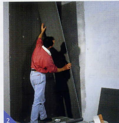
2 Les parois régulières se doublent de panneaux Wedi collés en plein. Dans ce cas, le receveur préformé (Wedi) se pose après.
