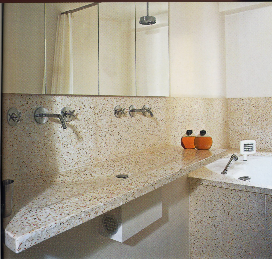
Le granito dans lequel est fabriqué ce plan intègre un mélange de ciment blanc, de granulats de marbre, de pâte de verre et de nacre. L'ensemble est malaxé avec des plastifiants qui l'imperméabilisent. © Réalisation Société Granito. Architecte G. Percal. Photo A. Duarte.
