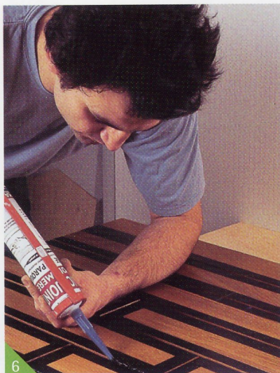
6 Le mastic s'applique en cordon continu, il doit remplir intégralement les vides et déborder largement.
