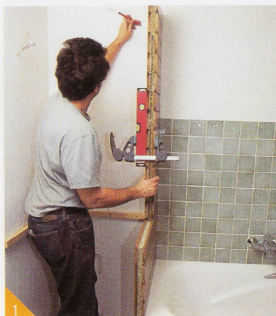
La cloison est provisoirement placée d'aplomb pour permettre de repérer l'emplacement des étagères.
